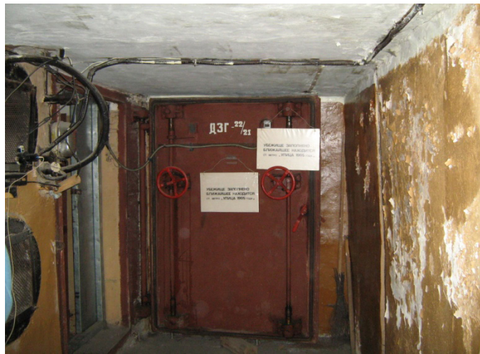
Рис. 2. Дверь защитно-герметическая перед тамбур-шлюзом убежища
