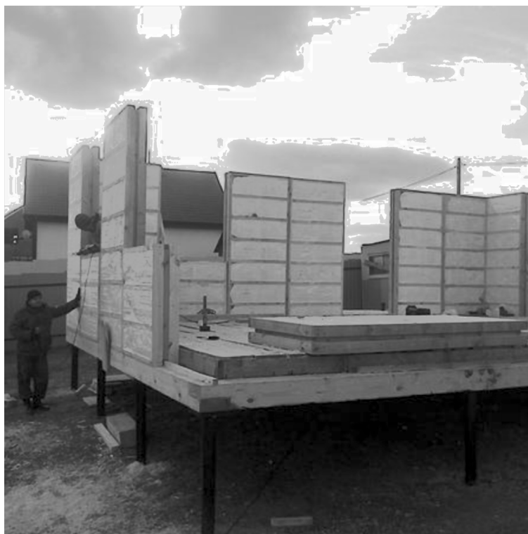
Рис. 3. Сборка стеновых панелей первого этажа дома
