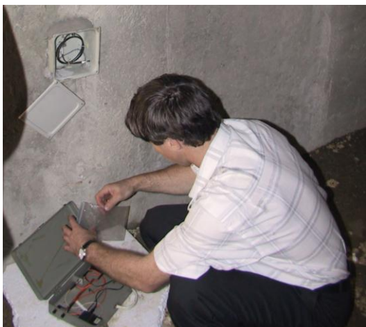
Рис.5. Контроль напряжений в железобетонном пилоне цокольного этажа многоэтажного дома
